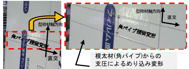
写真3 型枠変形状況の例(実大実験: t=50mm)
