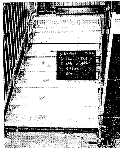
写真1. 階段変形状況
