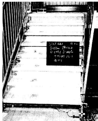
写真 6. 階段変形状況
