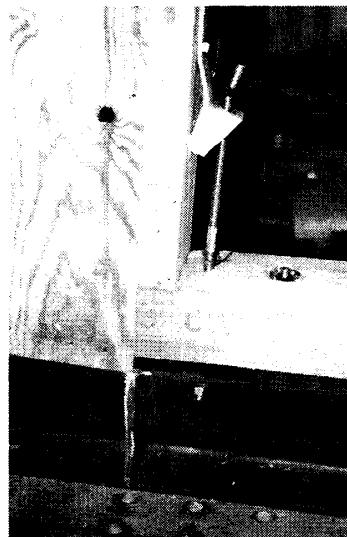
写真1 ホールダウン金物の曲がり
