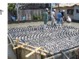
基礎コンクリート打設
