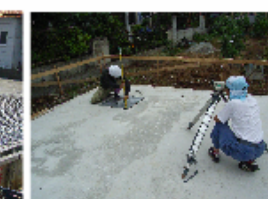
アンカープレート寸法調整
