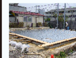
デッキ(キーストンプレート)敷き込み
