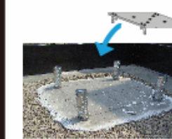
アンカーボルト用ボルト設置
