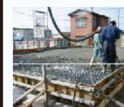
コンクリート打設状況
