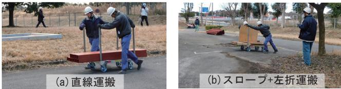
写真9. 覆工資材運搬状況
