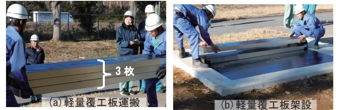
写真7. 軽量覆工板による開口部覆工
