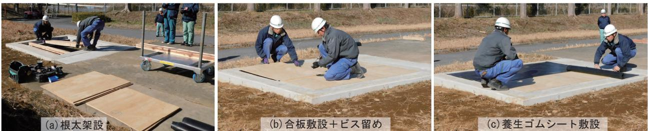
写真 5. 木床による開口部覆工
