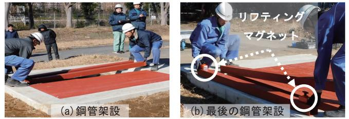
写真6. 鋼管による開口部覆工
