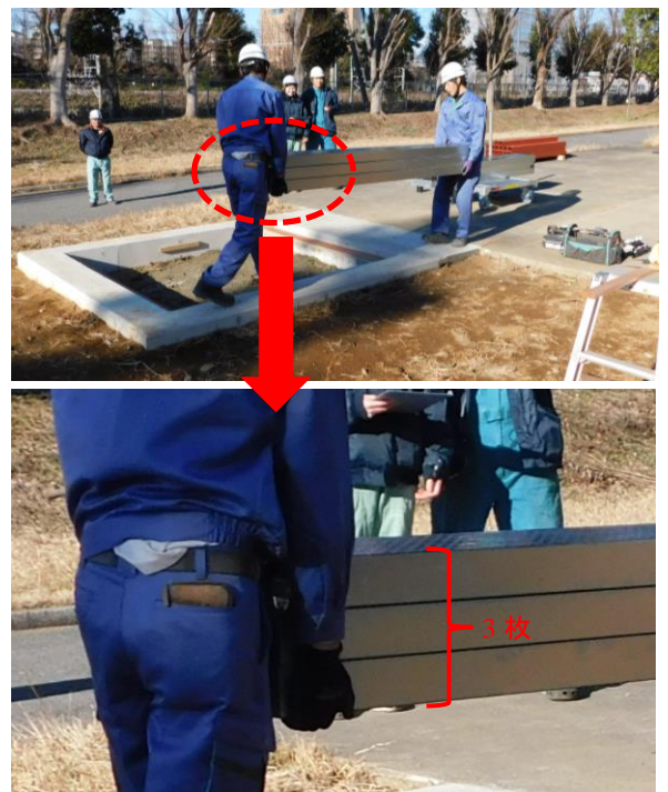
写真 3. 軽量覆工板運搬状況
