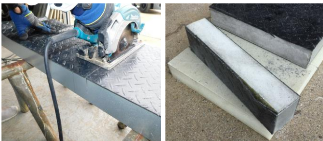
写真1. 電動丸鋸での切断
