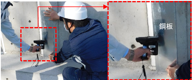
写真4 電波シールド材によるスリット位置確認
