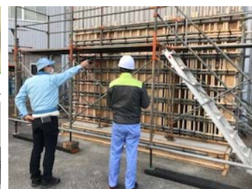
写真3 型枠組立時検査
