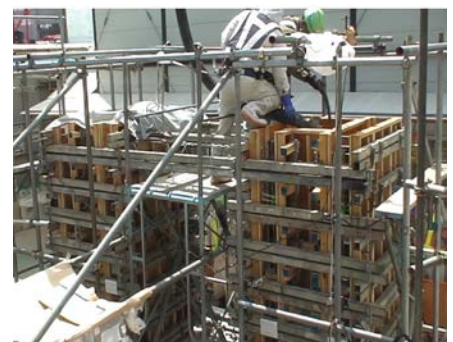
写真3. コンクリート打設状況
